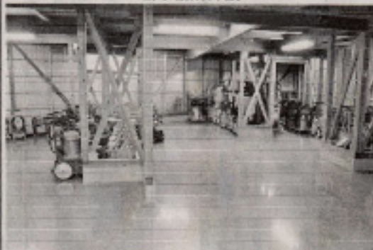
機械保管用として使用する1階倉庫
